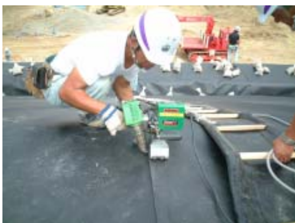
写真-1 自走式溶着機
