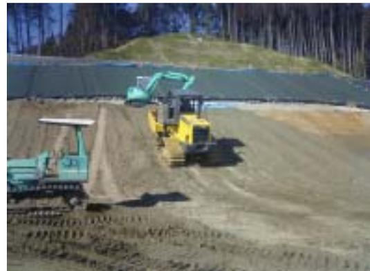
写真-2 クローラ駆動式ローラによる転圧状況
