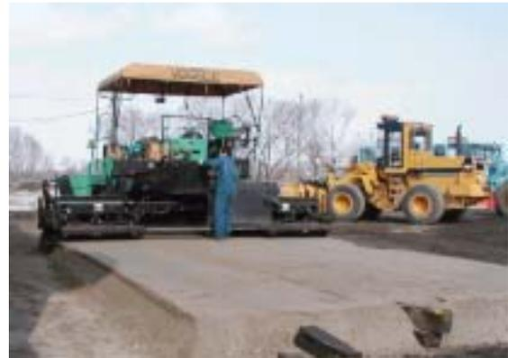
写真-1 コンクリートフィニッシャーによるBMSL敷設状況
