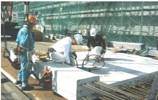
写真-1 吊り金具の取付け
