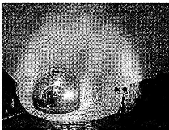
写真-2 ハイ・イータス工法によって施工された防水シートの状況
