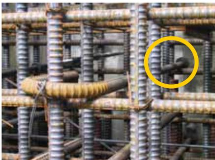
写真-4 Tヘッドバー適用例
