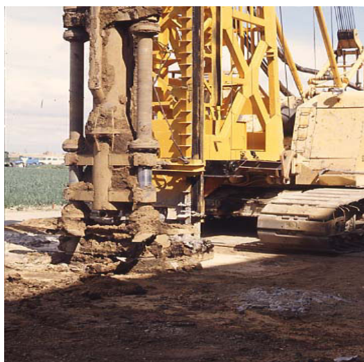
写真－1 深層混合処理工法の施工状況
