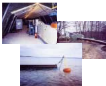
図-20 取水管現地溶着状況（KWH） 6)
