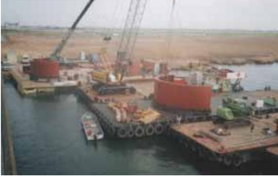
写真-8 鋼製パネル組立・曳航状況
