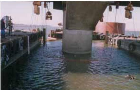
写真 - 10 鋼製パネル沈設状況
