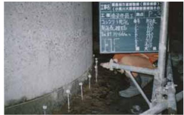
写真-13 橋脚補強状況（底部アンカー）
