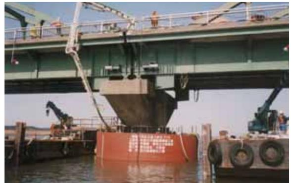
写真-14 橋脚補強状況（コンクリート打設）
