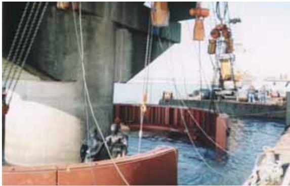
写真 - 9 鋼製パネル設置状況
