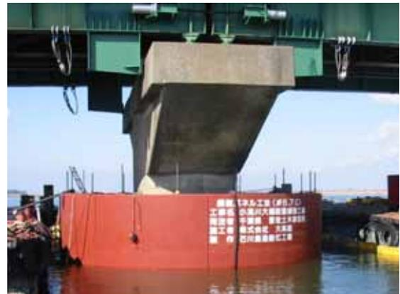
写真-1 鋼製パネル式仮締切
