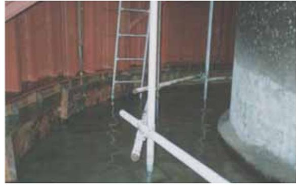
写真-12 締切内部の状況（水替直後）
