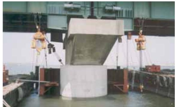
写真-15 鋼製パネル撤去状況
