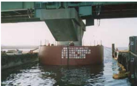
写真 - 11 鋼製パネル設置完了
