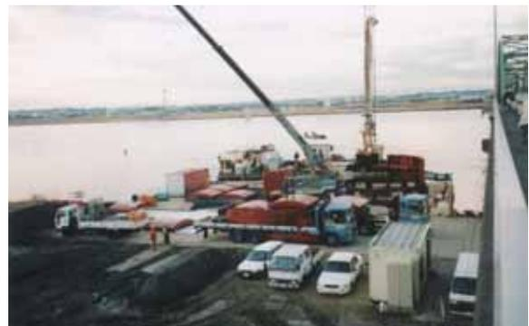
写真-7 鋼製パネル現地搬入状況
