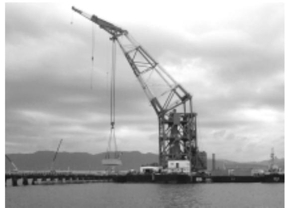
写真-6 Pca-Box据付状況
