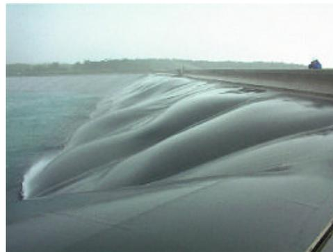
図-3 強風時のシート膨らみ状況
