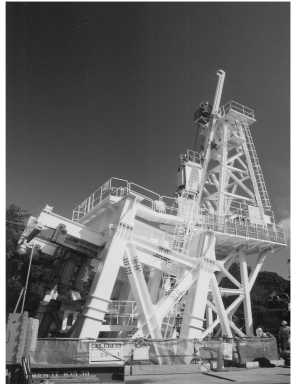
写真-1 地上仮設備
