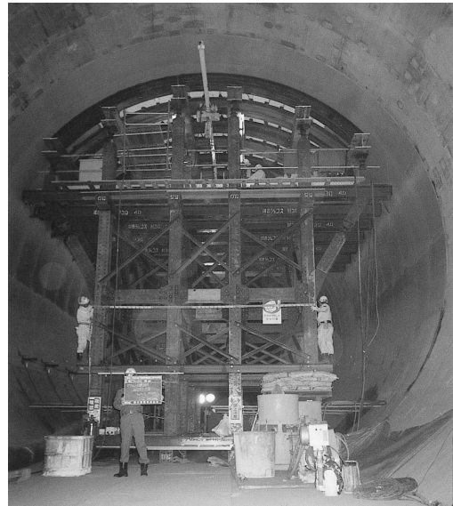
写真-2 既設セグメント変形防止用支保工
