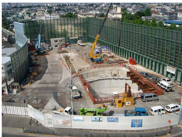
写真-1 発進立坑基地着手前
