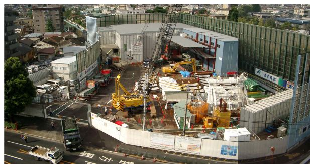
写真-4 本掘進時作業基地全景
