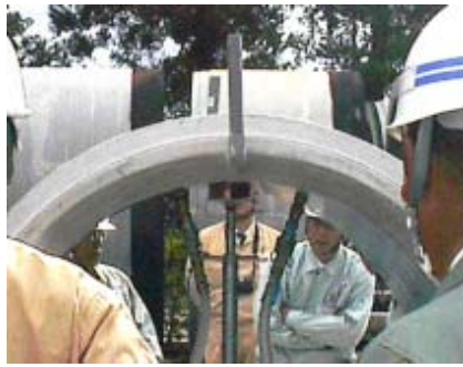
写真- 4 充填性目視確認の状況
