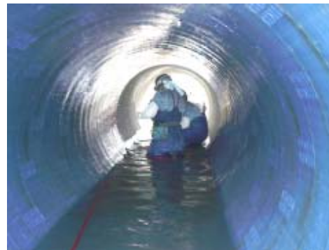
写真- 2 下水供用下施工の状況
