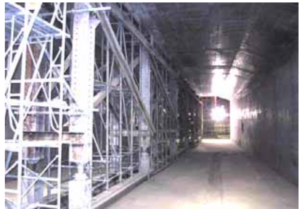
写真-6 環六BOX改築完了全景（外回り車線部を新宿から板橋方向を見る）
