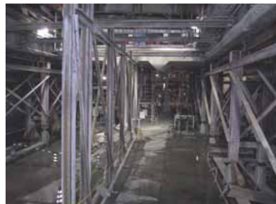
写真-4 環六 BOX 撤去状況全景
