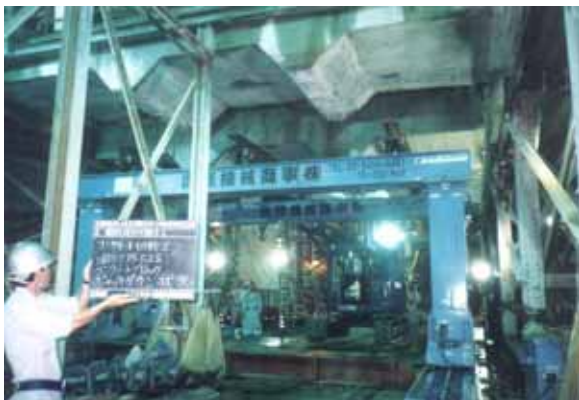
写真-3 油圧リフターによるブロック体吊下げ状況（頂版部）
