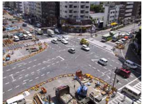
写真-1 工事箇所（要町交差点）全景
