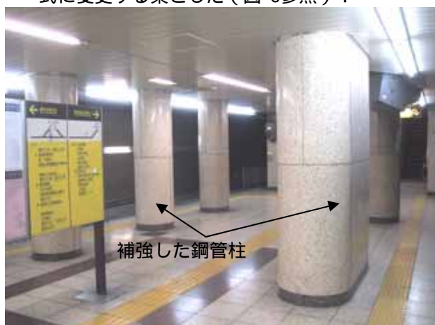
写真-2 駅ホム階補強柱
