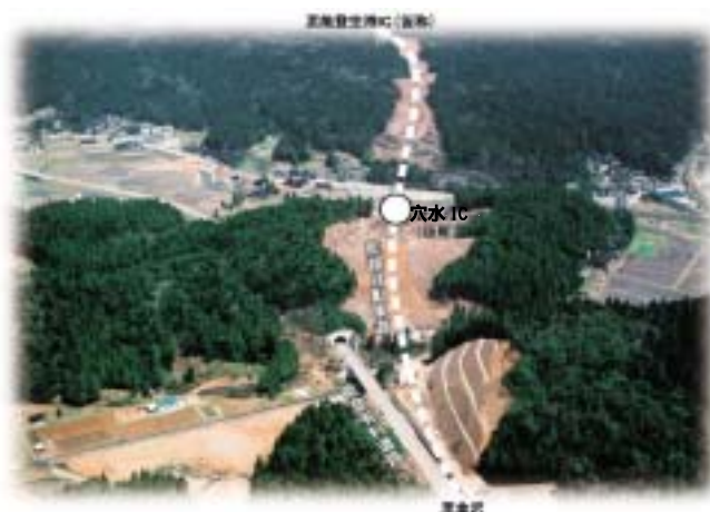
図-5 山間部を通過する穴水道路
