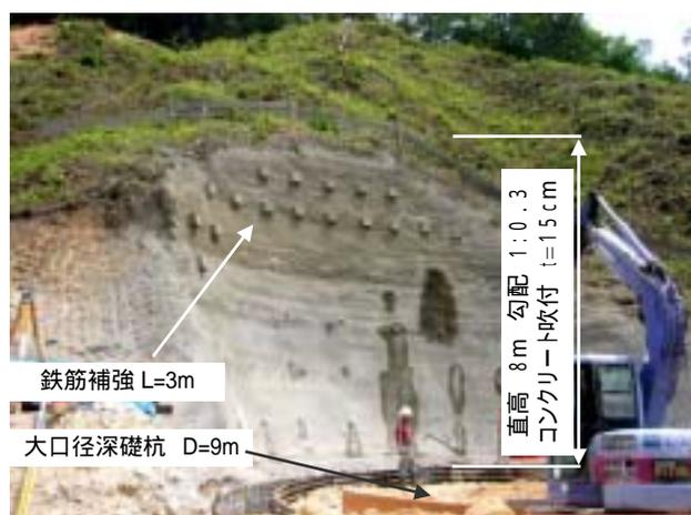
写真-9 橋脚の施工に伴い発生した切土のり面
