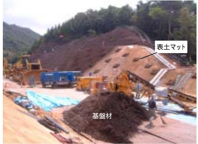
写真-14 建設発生木材と表土を混合した基盤材の吹付け
