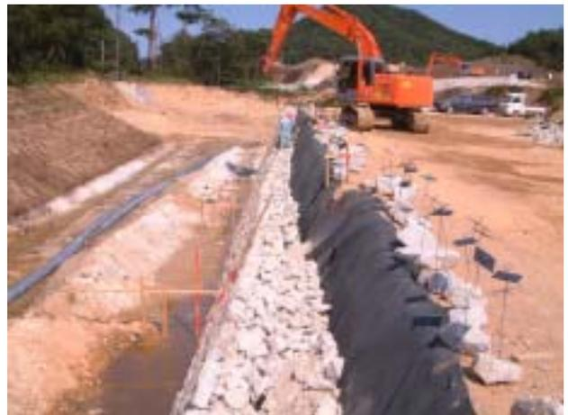
写真-5 空石積み自然石護岸工の施工
