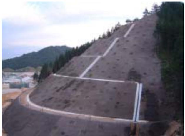
写真-7 完成した長大切土のり面
