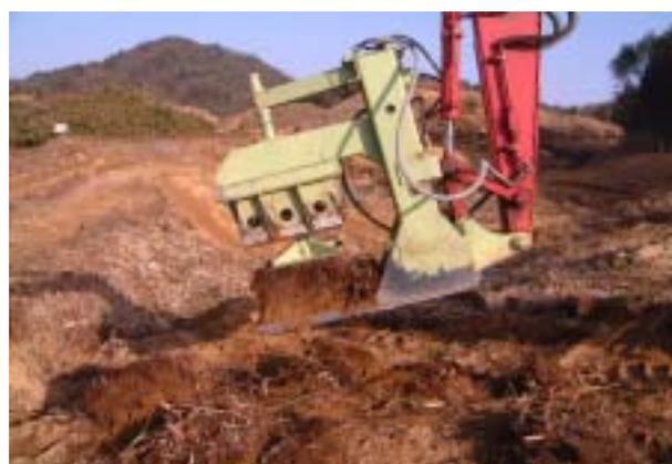
写真-11 採取機による表土マット採取状況
