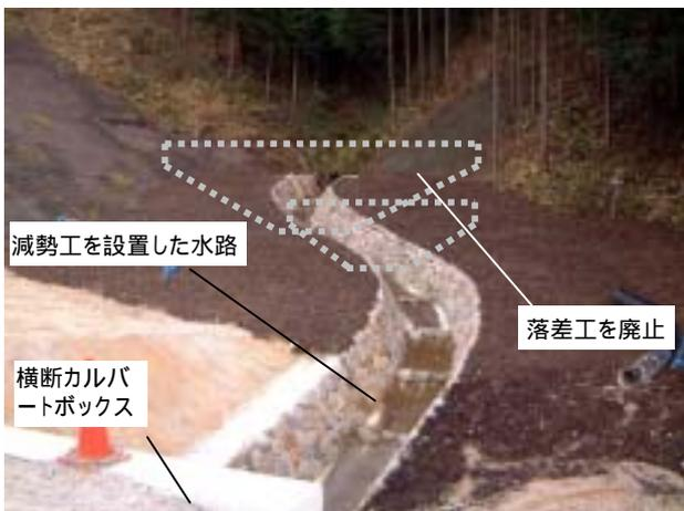
写真-17 動物の移動を確保したカルバート入口部
