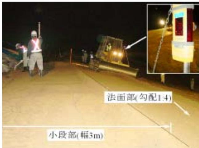
写真 - 4 夜間レーザーレベル施工状況
