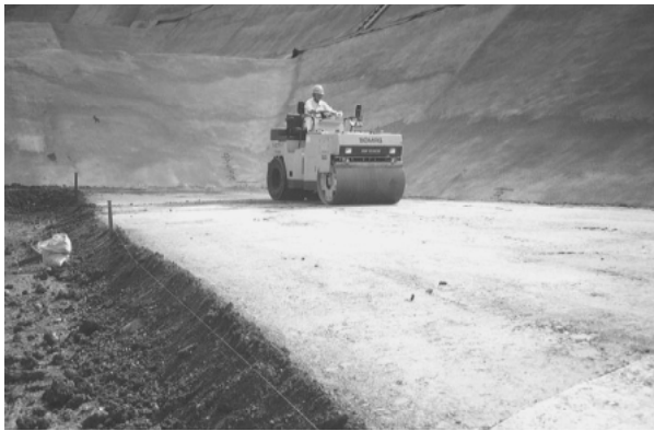
写真-3 施工状況（水平部転圧状況）
