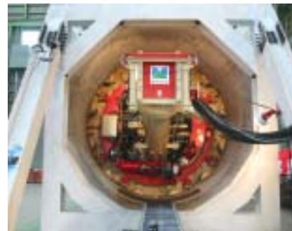
写真-3 2リング目組立完了
