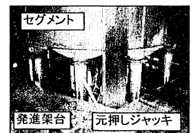
写真-4 元押しジャッキ設置状況
