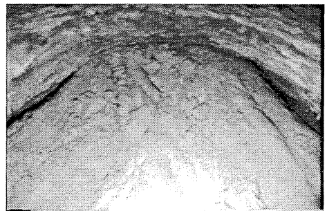
写真-5 完成した離隔壁
