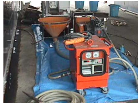
写真-12 流量測定状況
