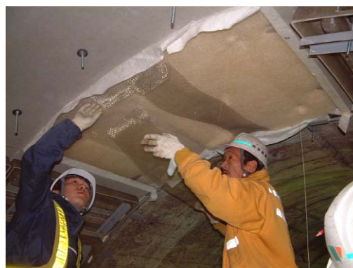
写真-5 ステンレスメッシュ取付状況
