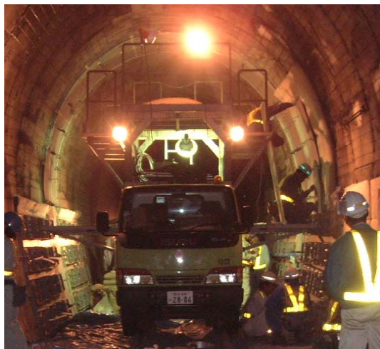
写真-13 移動足場（軌陸車）の例
