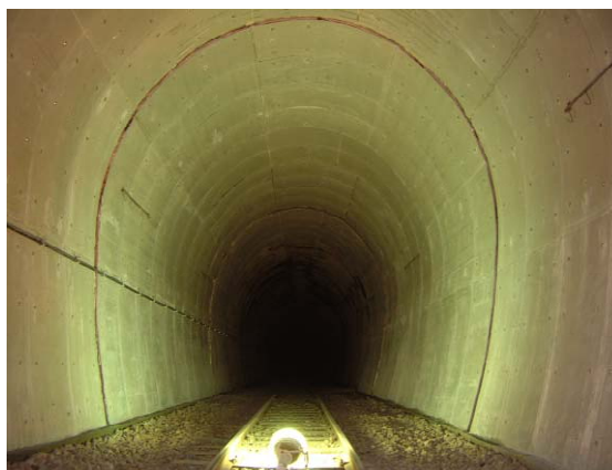
写真-16 施工完了後の状況
