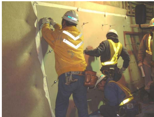
写真-6 短繊維補強ボード取付状況
