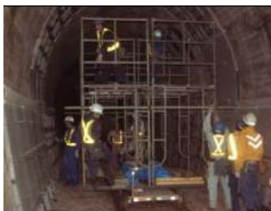
写真-14 移動足場（トロ台車）の例
