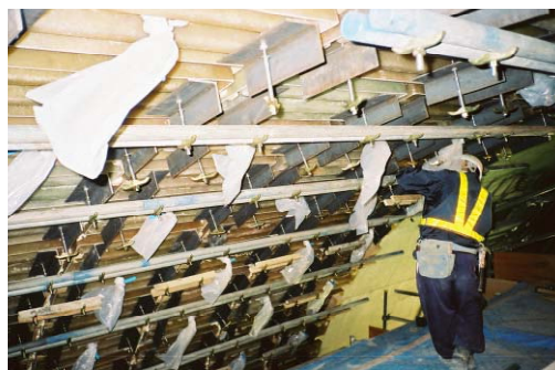
写真-9 グラウト材充填確認状況
