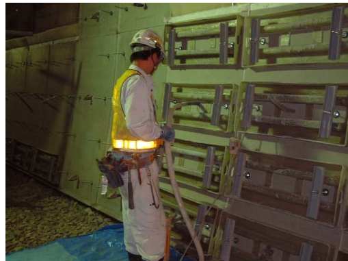
写真-8 グラウト材注入状況
