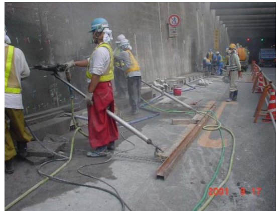
写真-2 レッグドリルによる穿孔
