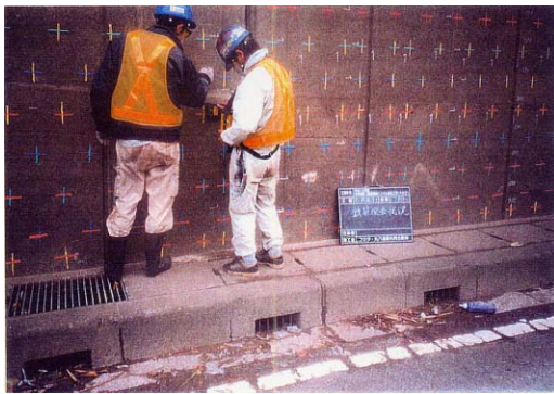
写真-3 内部探査機による調査
