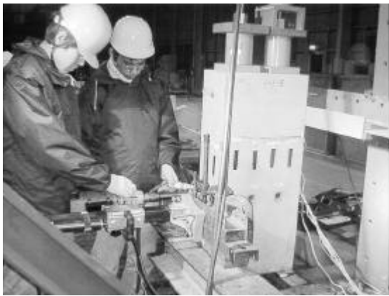
写真-4 コアリングの状況
