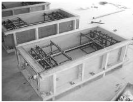
写真-1 型枠および配筋の状況
