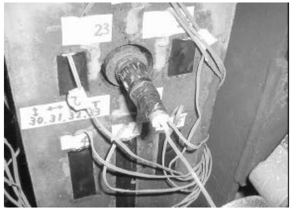
写真-5 コアリングの状況 (完了時)
