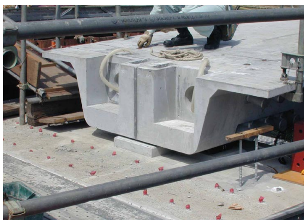
写真 - 3 桁端部（桁架設時）
