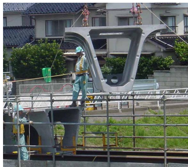
写真 - 2 中央ブロックの架設
