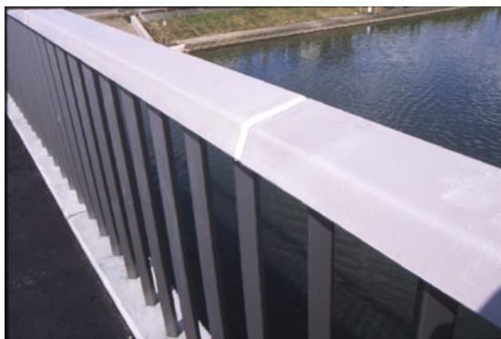
写真-9 ダクトアル製トップレール（笠木）
