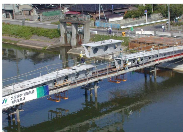
写真-8 ブロック架設状況
