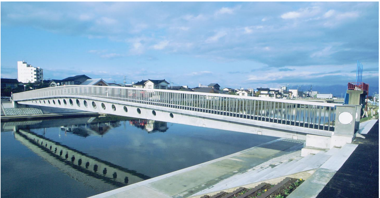
写真 - 1 酒田みらい橋
