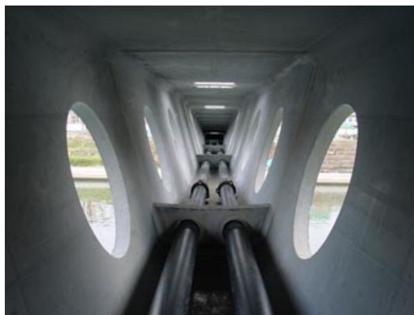
写真 - 5 桁内部状況
