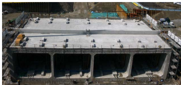
写真-2 函体設置完了全景(第3-1函体)
