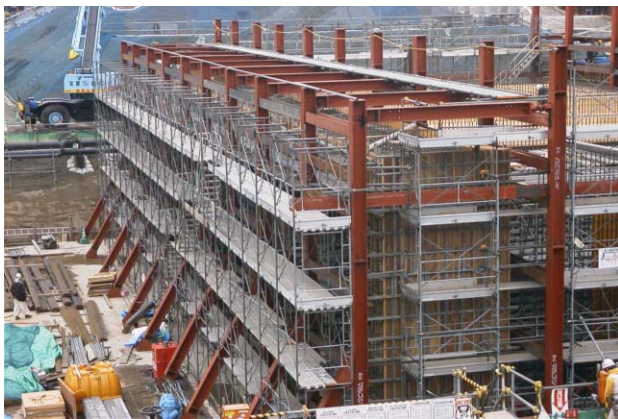
写真-1 型枠構台工組立完了全景 (第3-1 函体)
