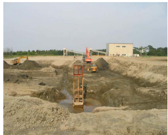
写真-1 浚渫土砂搬出状況
