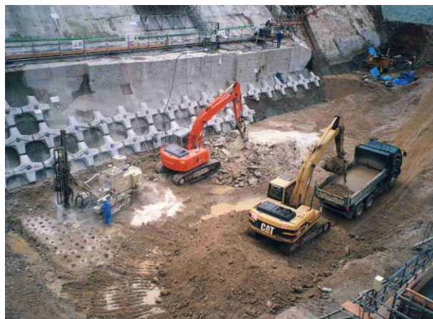
写真-1 掘削工事状況
