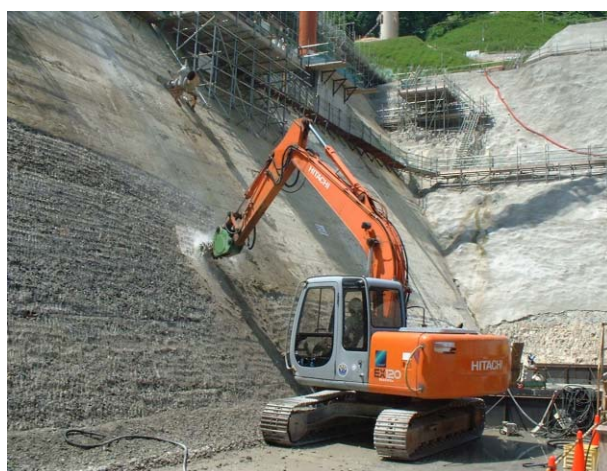
写真-2 既設堤体下流面チップング状況
