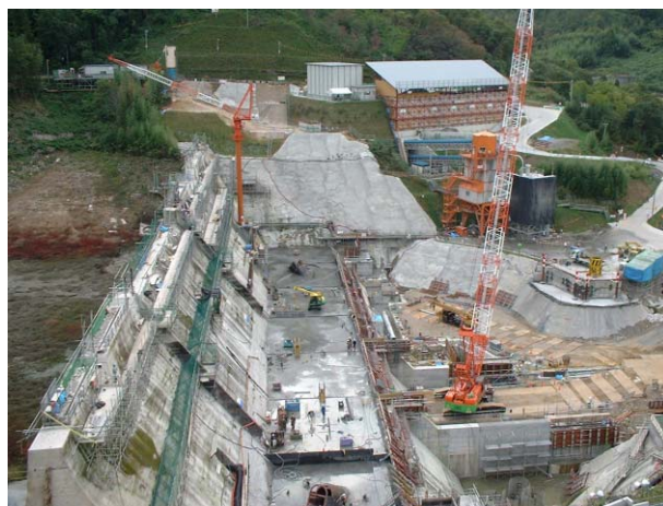
写真-3 堤体コンクリート打設状況
