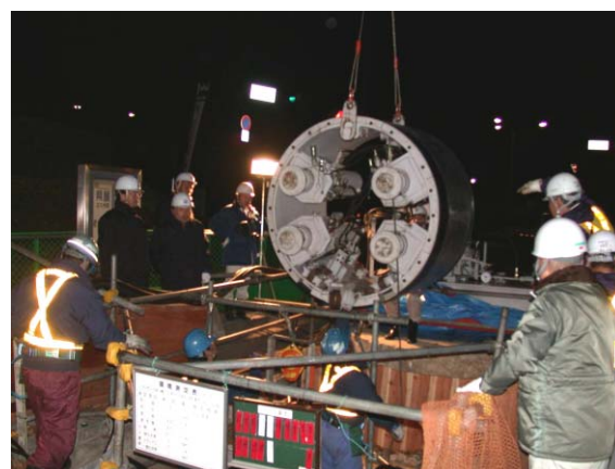
写真－７ バックス工法 実証工事状況
