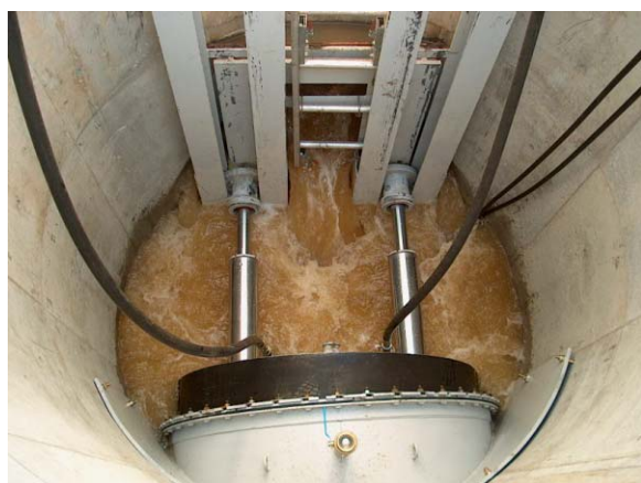
写真－5 更生管推進状況
