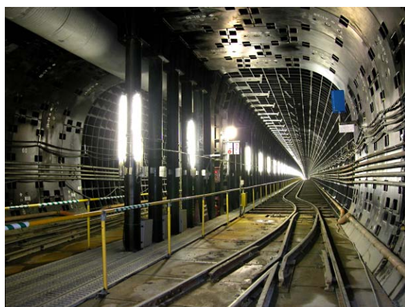
写真－４ 接続部（合成からDCセグメント区間を望む）
