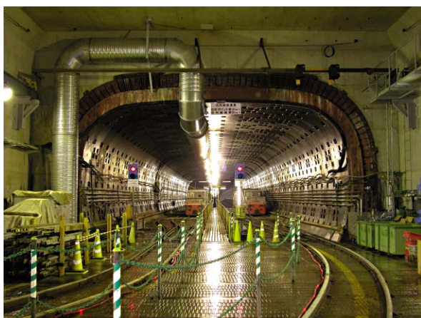
写真－３ 坑口及び合成セグメント区間
