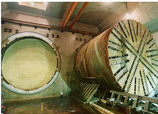
写真-1 到達状況（バルク解体完了）
