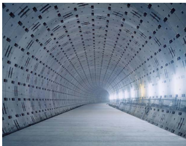
写真-4 西新宿シールドトンネル完成写真
