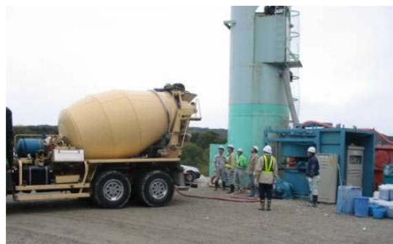
写真- 3 充填材の製造状況
