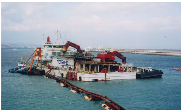
写真-1 分級専用揚土船（揚土 600\text{m}^3/\text{hr} ）
