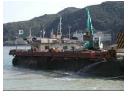
写真-1 ブラインド覆砂工法
