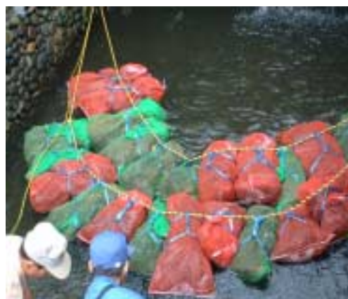
写真-3 炭設置(釜川)
