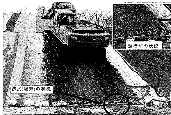
写真-6 重機走行試験状況
