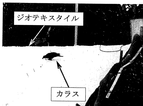
写真-1 カラスによるジオテキスタイル損傷状況
