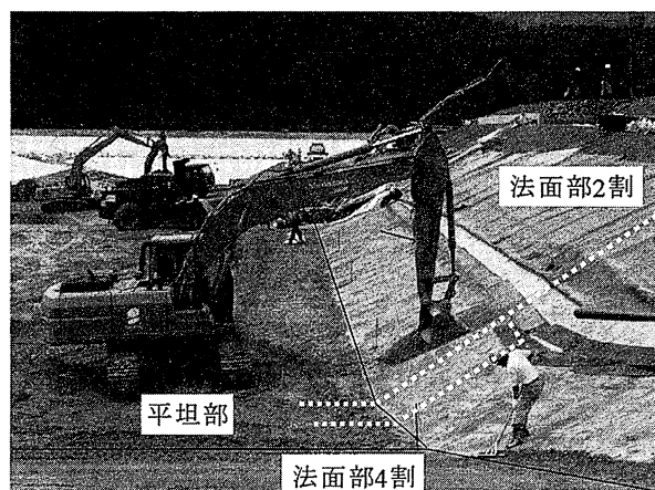
写真-1 旭川市廃棄物処分場施工状況
