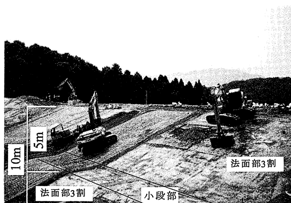
写真－２ 浜北市最終処分場の施工状況
