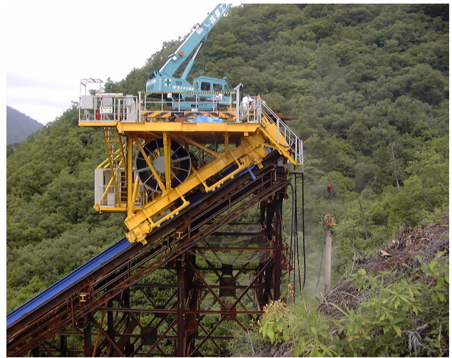
写真-1 架台延伸作業状況
