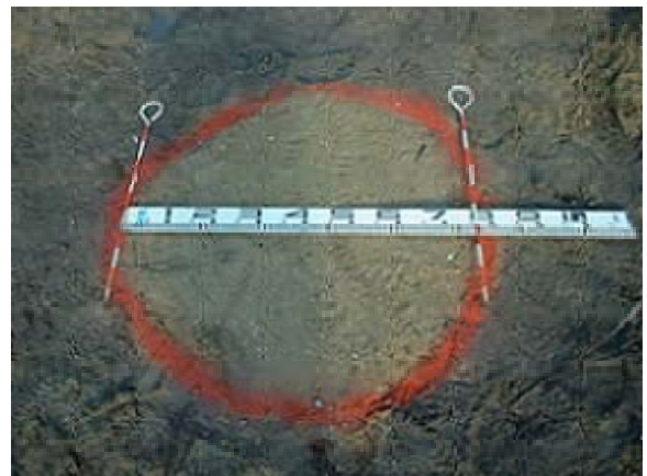
写真 - 1 出来形（杭径）確認
