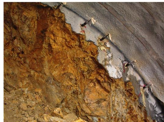
写真-3 AGF-HITM 区間掘削状況
