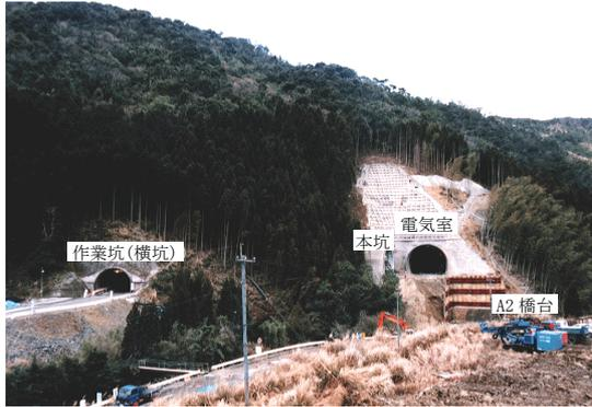
写真-4 坑口部掘削完了状況
