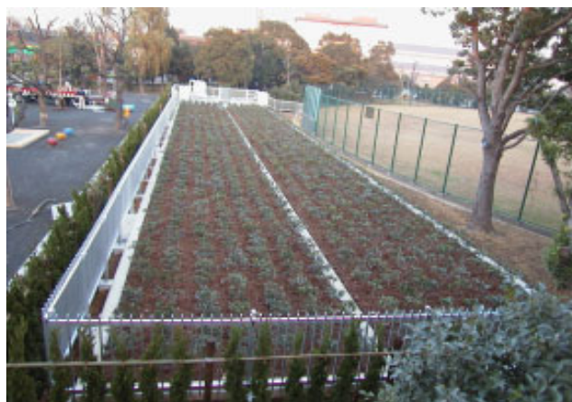
写真-1 施工例-1 (池上新田公園)
