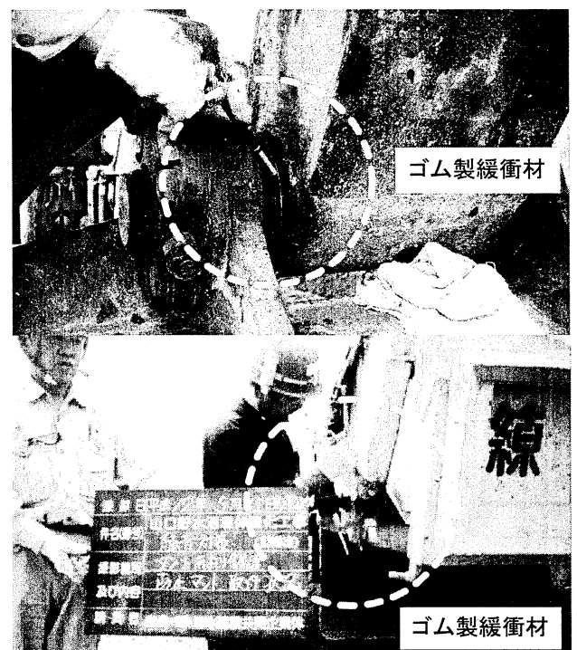
写真-6 金属音低減対策
