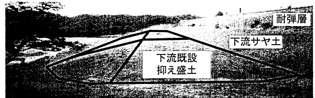
写真-3 下流既設抑え盛土
