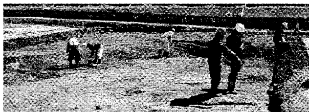
写真-9 仕上げ掘削状況
