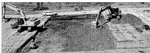
写真-10 堤敷部における小規模盛立状況
