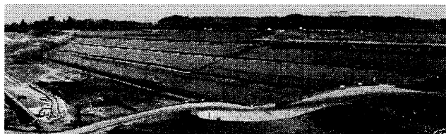
写真-6 既設堤体上流側全景(2000年1月)
