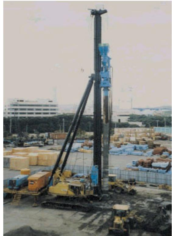
写真-3 SDP施工機全景
