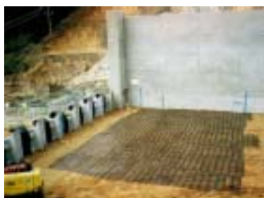
(a) ジオグリッド敷設
