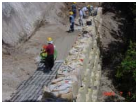
写真 - 8 適用事例その 3 (施工状況)
