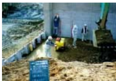
(b) 盛土敷均し、改良土転圧
