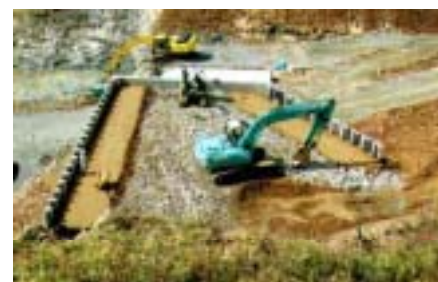
(c) 盛土敷均し
