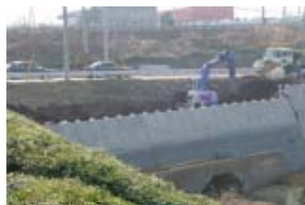
(c) 施工状況遠景
