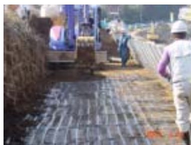
(b) ジョグリッド敷設, 盛土敷均し
