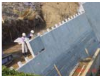
(a) パネル設置
