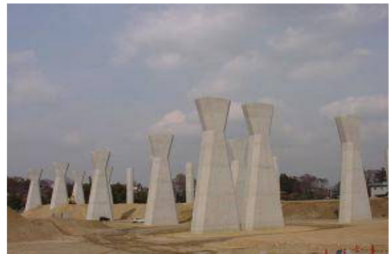
写真-1 あきる野IC下部（その5）工事全景
