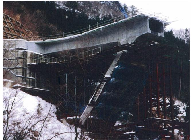
写真-3 側径間部施工状況
