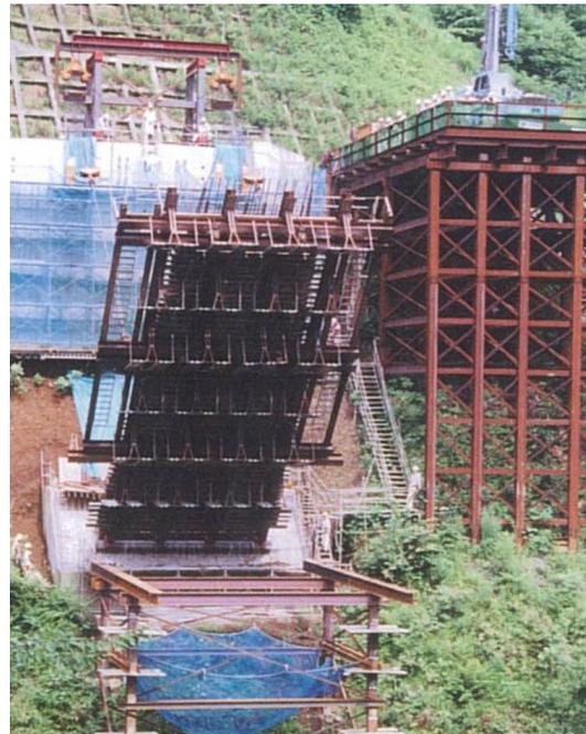
写真-2 斜材支保工引上げ後の状況
