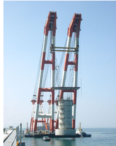
写真-1 スカート吊曳航状況
