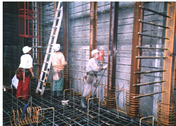
写真-4 突起付きH形鋼設置状況
