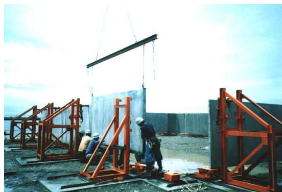
写真-1 高耐久性埋設型枠組立て状況
