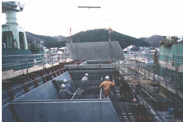
写真-10 遊水室高耐久性埋設型枠設置状況
