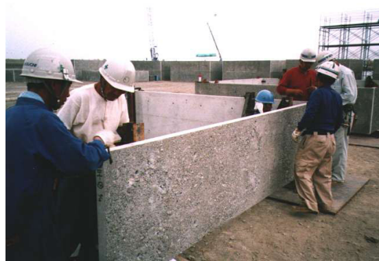
写真-2 RCプレキャスト埋設型枠組立て状況
