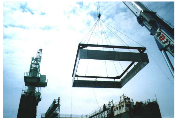
写真-3 高耐久性埋設型枠設置状況
