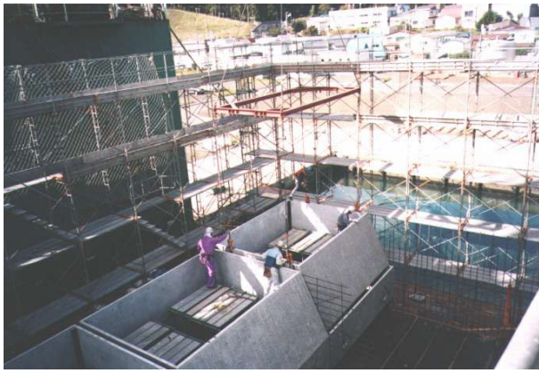
写真-8 RC プレキャスト埋設型枠設置状況
