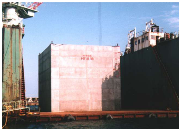
写真-7 防波堤ケーソンの完成
