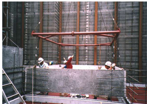
写真-5 RC プレキャスト埋設型枠組立て状況
