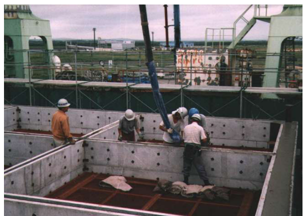
写真-6 流動コンクリート打設状況
