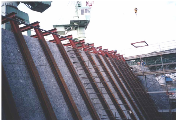
写真-9 遊水室背面突起付きH形鋼設置状況
