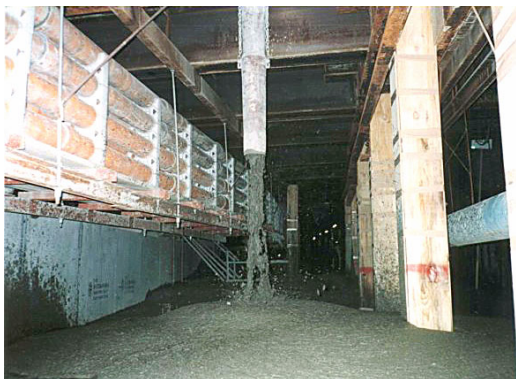
写真-1 流動化処理工法の施工状況
